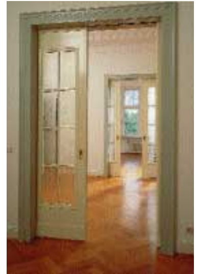
Originalgetreue Sanierung der Details
