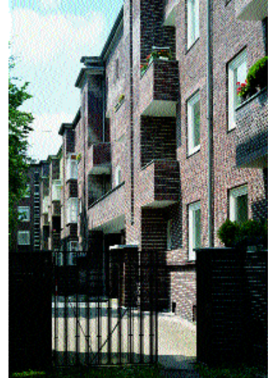
Blick in den Innenhof der „Gartenstadt Kreuzkampe“ vor Sanierung
