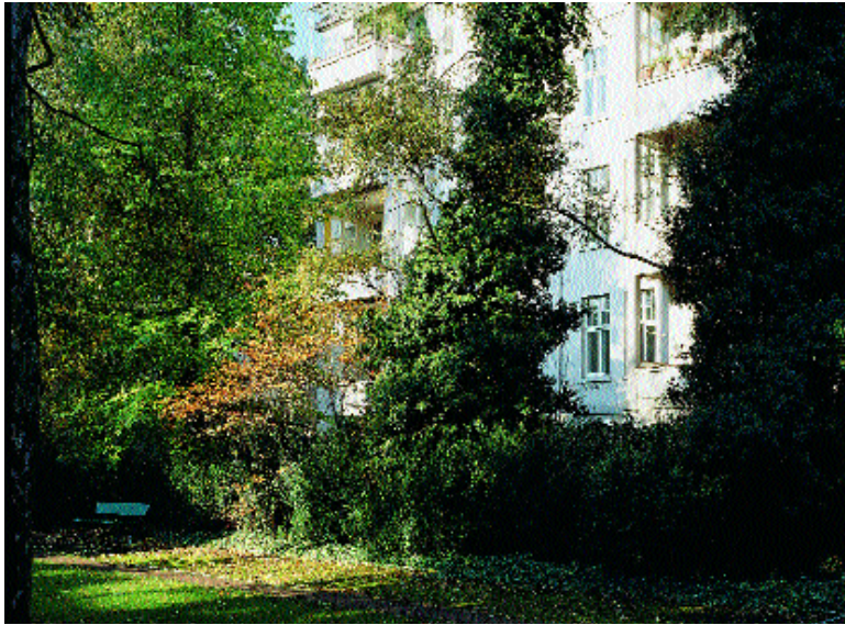
Gartenansicht vor Sanierung „Kontorhaus Remberti“ / Bremen
