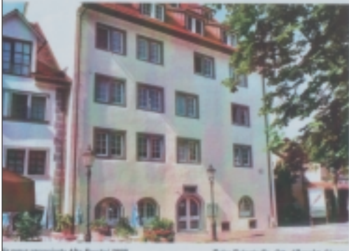
Die Forsteig renovierte Mitte Forsteig 1999
