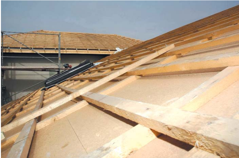
Dachdämmung aus Zellstoff
