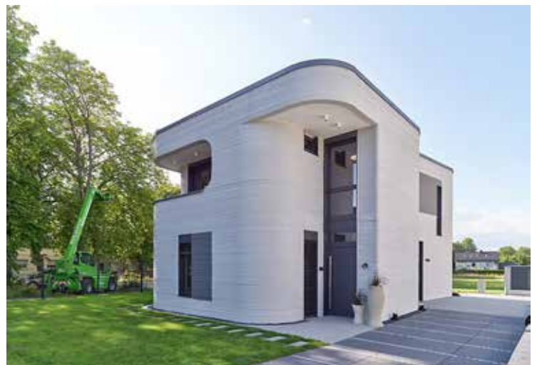
Deutschlands erstes 3D-gedrucktes Wohnhaus in Beckum – realisiert von PERI.
