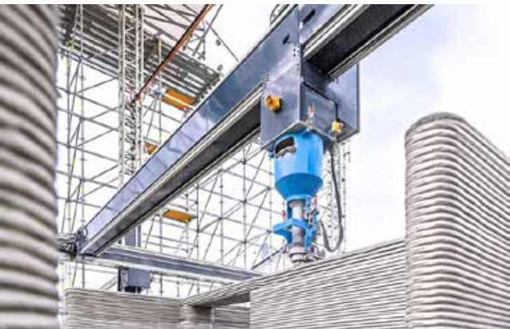
3D-Betondrucksystem der PERI GmbH – weltweit im Einsatz
